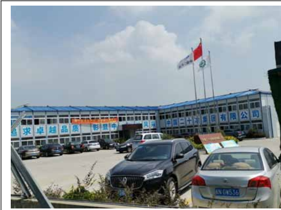
项目西侧科技港二期的临时营地
