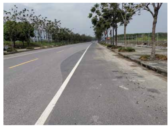
项目南侧长涛路
