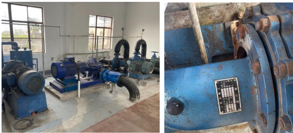
图 3.4-6 现状合兴增压泵站照片
