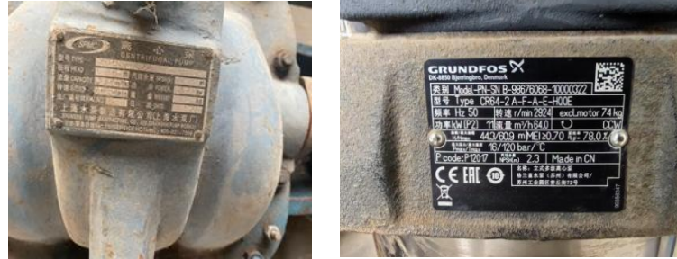
图 3.5-7 现状向化泵站、前哨泵站照片
