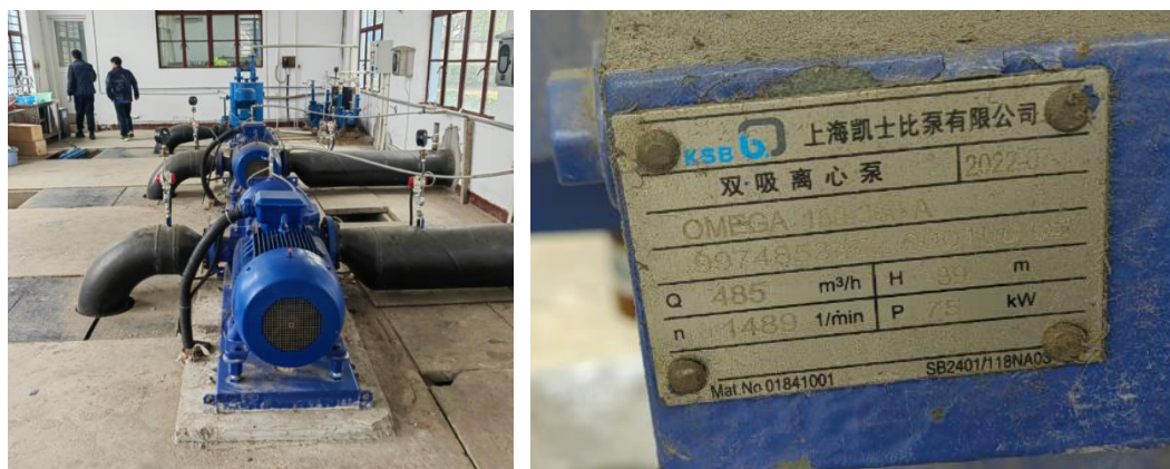
图 3.3-6 现状新河增压泵站照片
