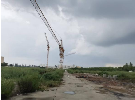
厂区南侧为在建工地
