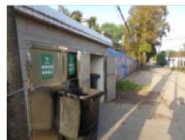
华星村海桥 0030 号垃圾房暴露垃圾
