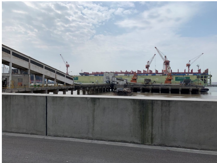
(3) 南侧长江大堤
