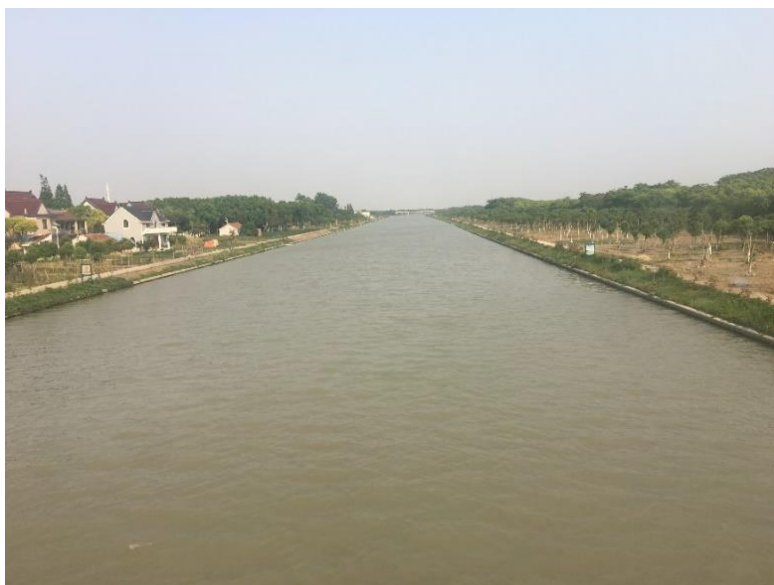
图 2.5-1 南横引河现状
