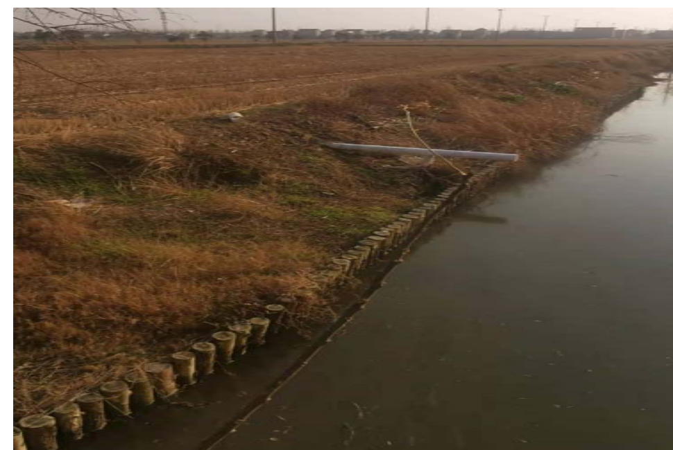
新浜北机口引水河现状图
