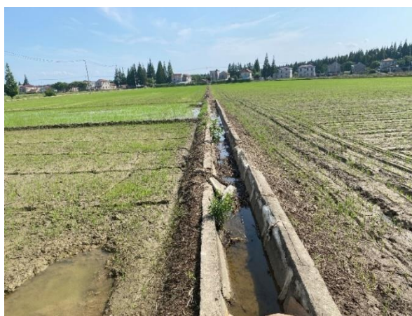
图 4.4-3 沿线灌溉沟渠实景照片
