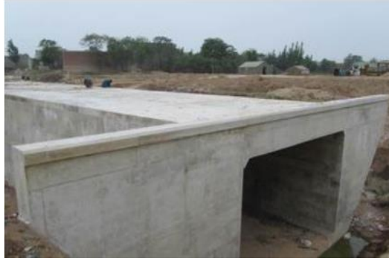
图 2.2-4 钢筋砼箱涵样例
