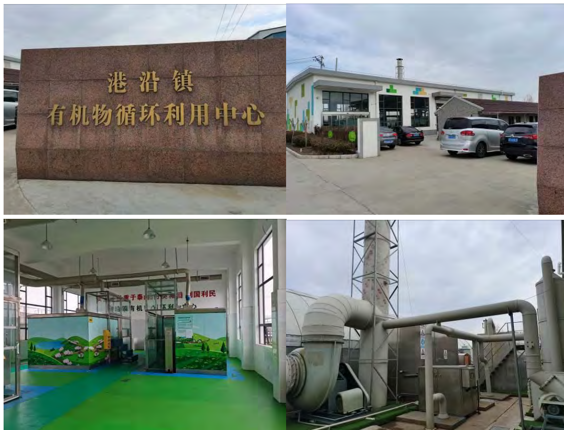
图 9-13 港沿镇有机物循环利用中心现场图
