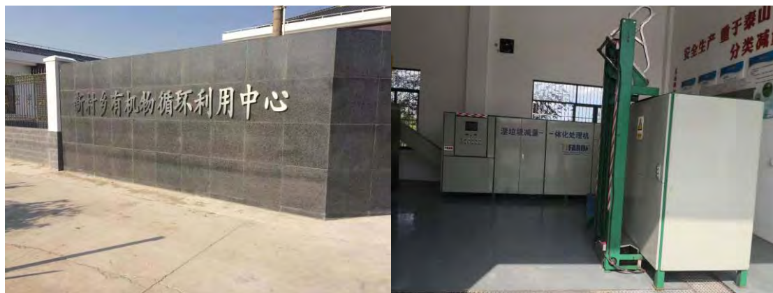
图 9-7 新村乡有机物循环利用中心现场图
