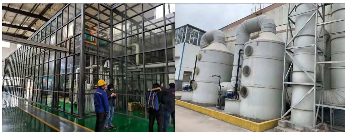
图 9-2 餐厨垃圾处理厂现场图
