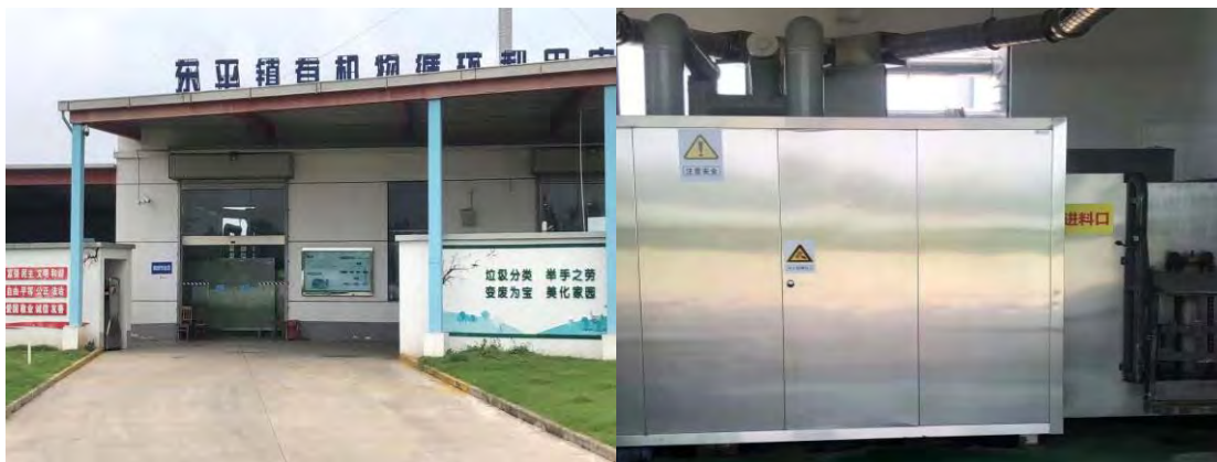
图 9-15 东平镇有机物循环利用中心（长江）现场图
