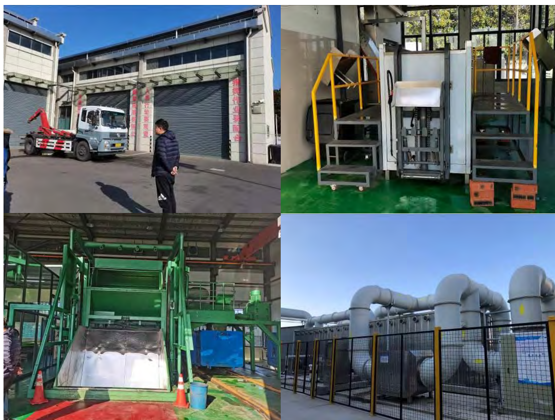
图 9-3 城桥镇有机物循环利用中心现场图
