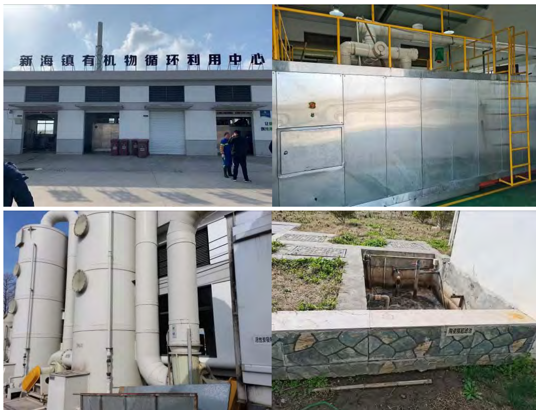
图 9-14 新海镇有机物循环利用中心现场图
