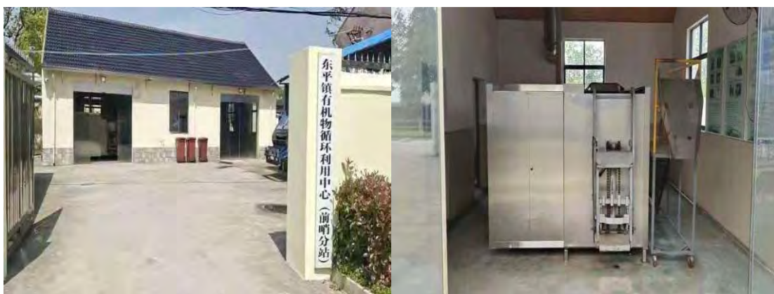
图 9-16 东平镇有机物循环利用中心（前哨）现场图
