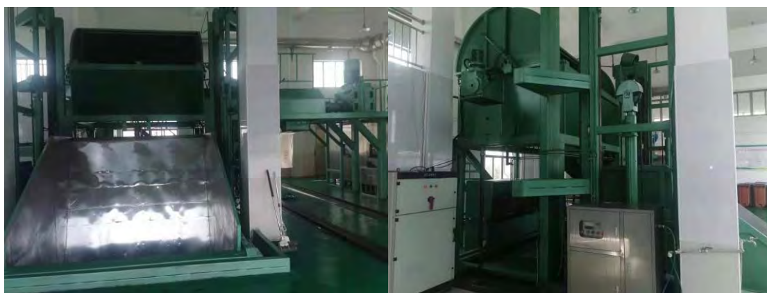
图 9-4 横沙乡湿垃圾处理设施现场图
