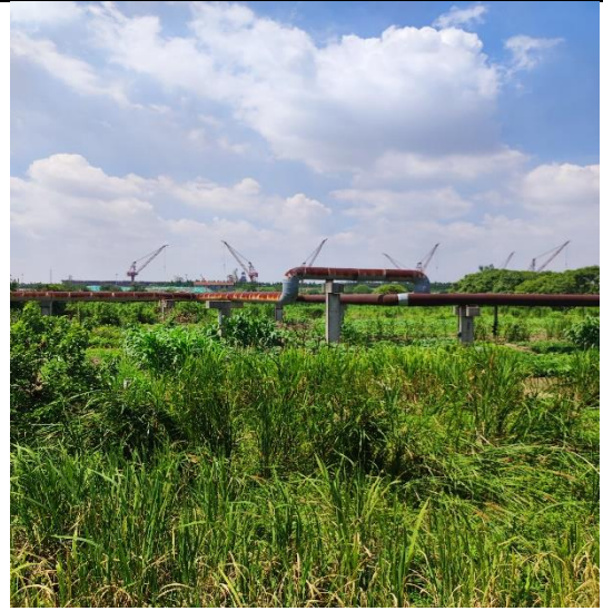
管道沿线现状（荒地）
