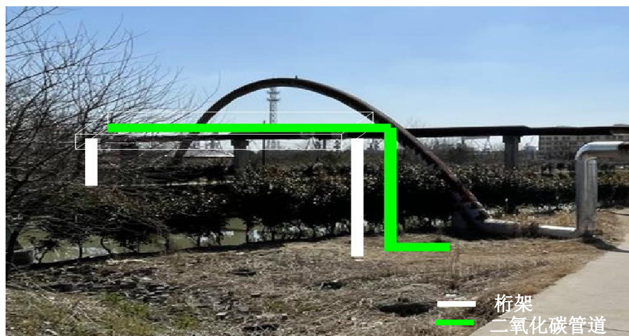
图 5 项目过新开港河采用桁架跨越
