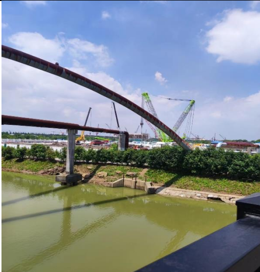
管道沿线现状（跨越新开河港）
