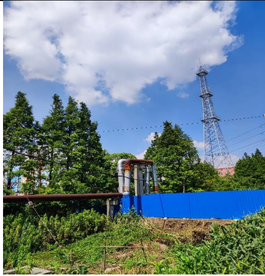
管道起点现状（荒地）
