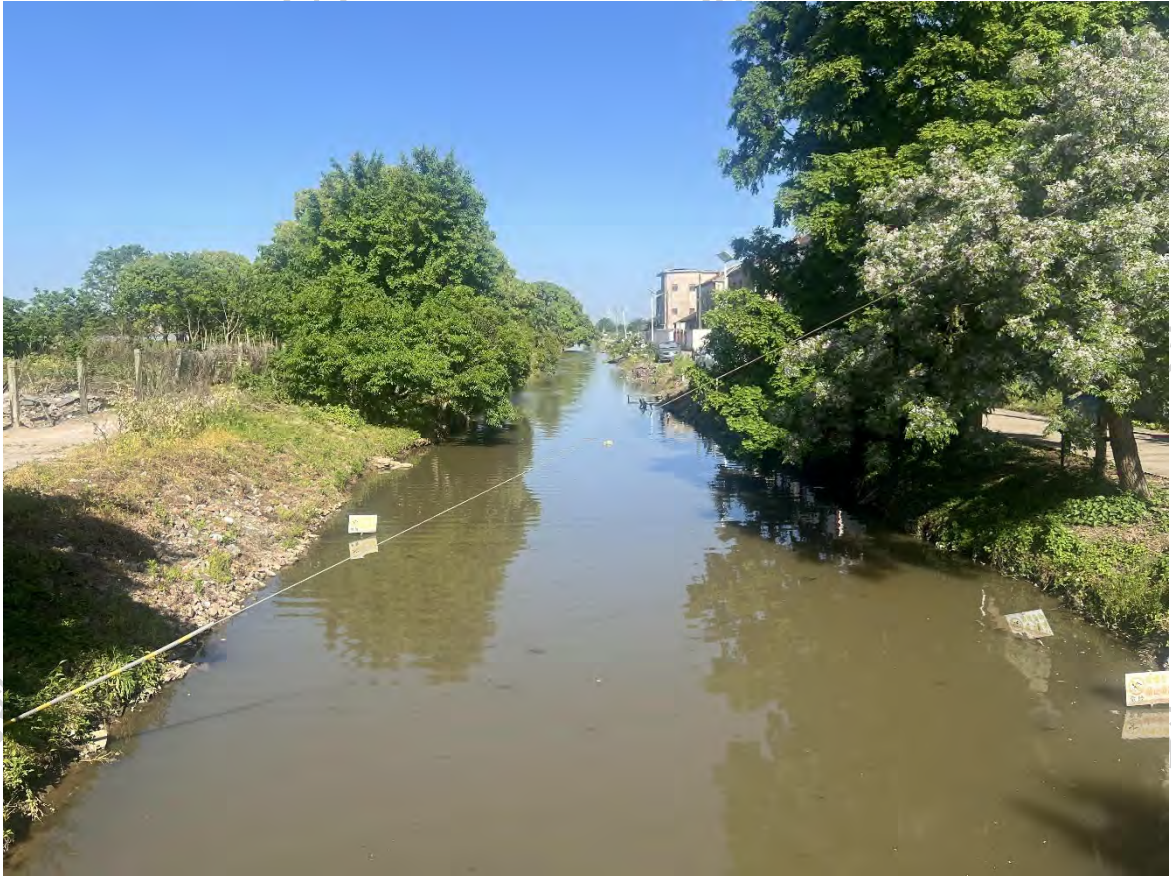
图 4-12 建设圩河现状照片
