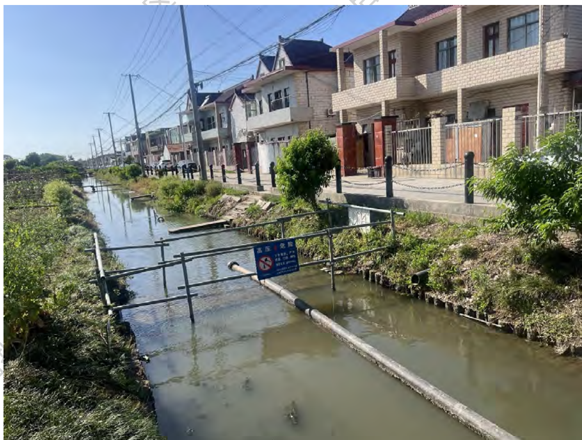
图 4-14 新兴支路东侧河现状照片
