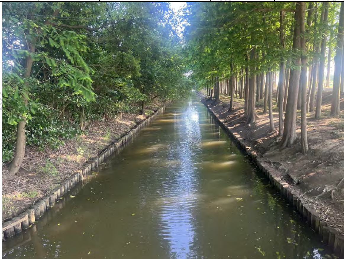
图 4-8 前卫支路河现状照片
