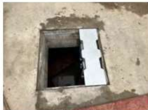
码头污水收集池
