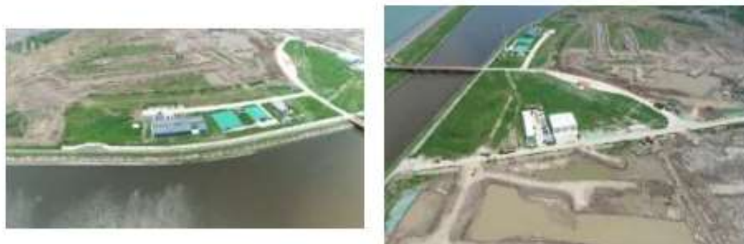
图 3.4-4 施工临时基地恢复情况
