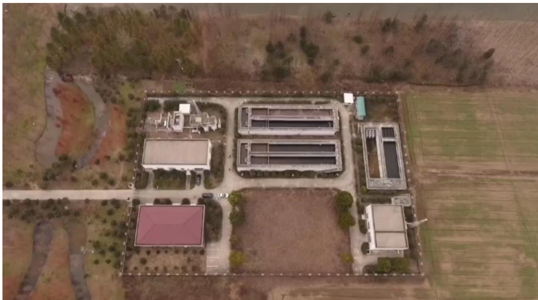
图 2-4 污水厂布局现状航拍图
