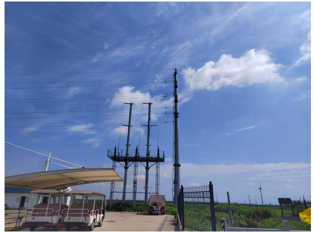
裕安项目 110kV 升压站并网装置
