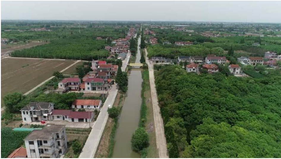
附图 10-5 河道桩号 0+955~2+805 河段现状
