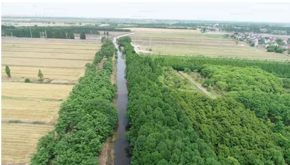
附图 10-18 河道桩号 12+050~12+707 河段现状
