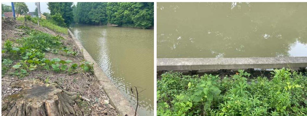
附图 10-12 现状桩板式护岸
