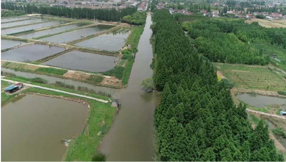
附图 10-1 河道桩号 0+055~0+255 河段现状
