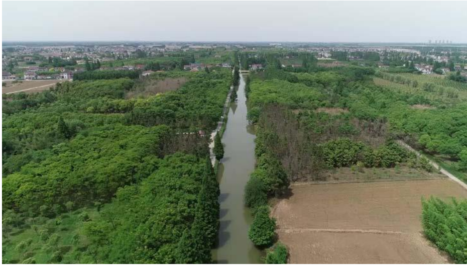
附图 10-13 河道桩号 9+605~10+270 河段现状
