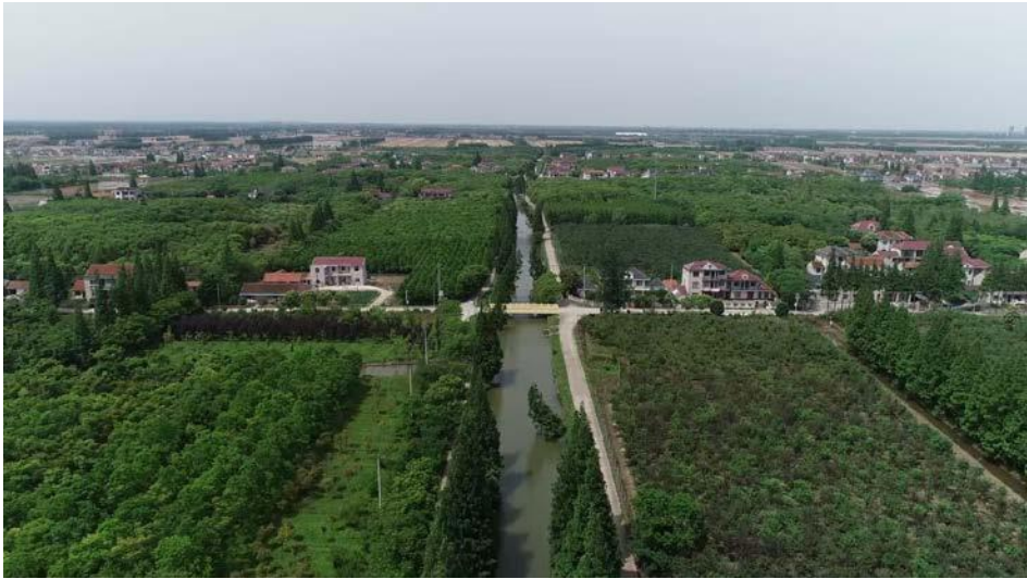
附图 10-14 河道桩号 10+270~11+180 河段现状
