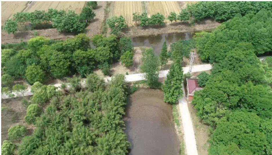
附图 10—17 现状阻水坝基
