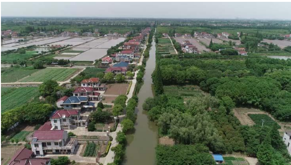
附图 10-9 河道桩号 4+891~6+255 河段现状
