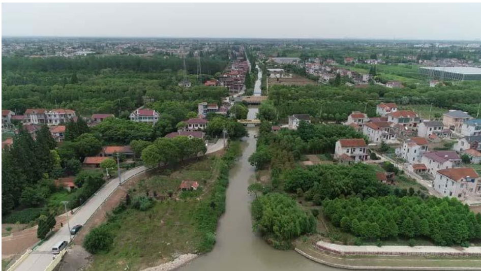
附图 10-6 河道桩号 2+805~3+125 河段现状
