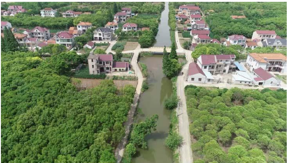
附图 10-15 河道桩号 11+180~11+180 河段现状
