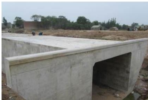
图 2.3-6 钢筋砼箱涵样例
