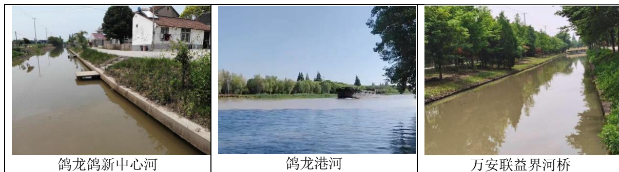
图 4.4-1 沿线跨越现状河道实景照片
