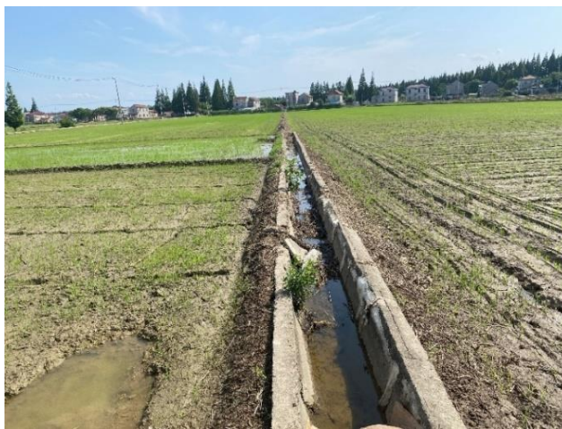
图 4.4-2 沿线灌溉沟渠实景照片
